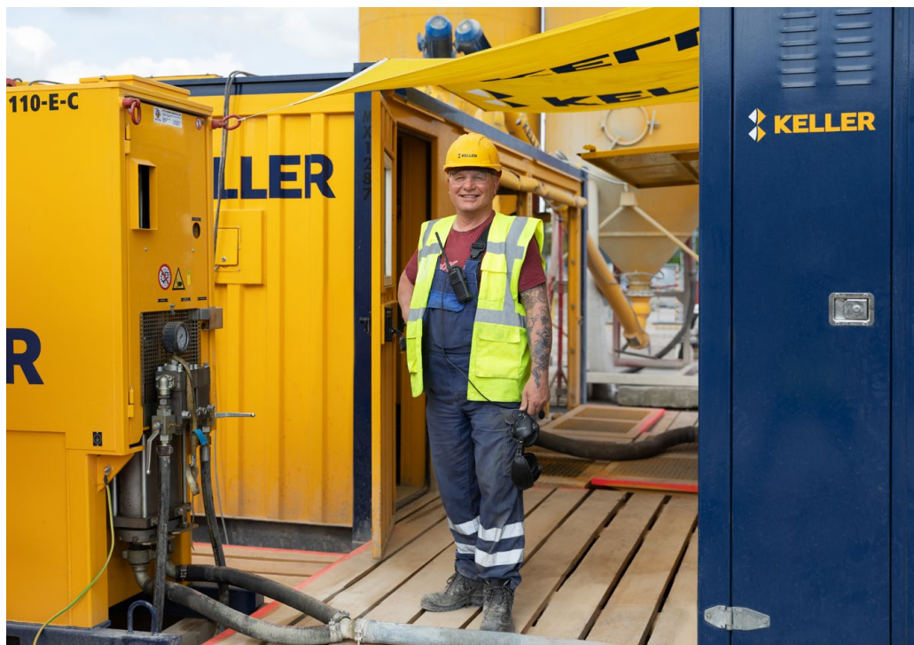
Heiko sorgt für Mischung und Hochdruck bei den Düsenstrahlarbeiten
