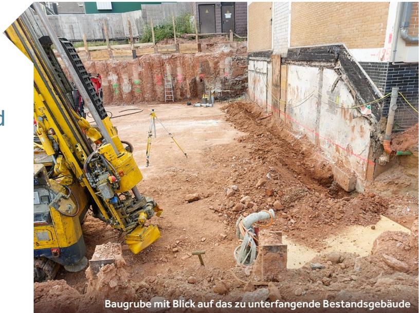
Baugrube mit Blick auf das zu unterfangende Bestandsgebäude
