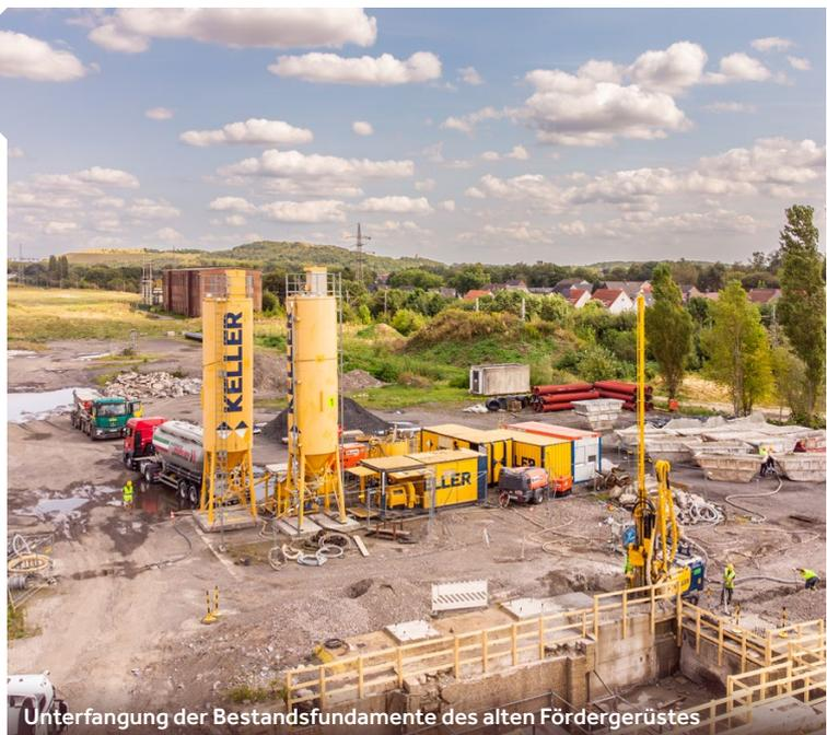
Unterfangung der Bestandsfundamente des alten Fördergerüsts
