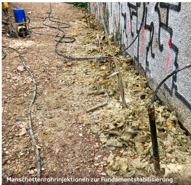
Manschettenrohrinjektionen zur Fundamentstabilisierung
