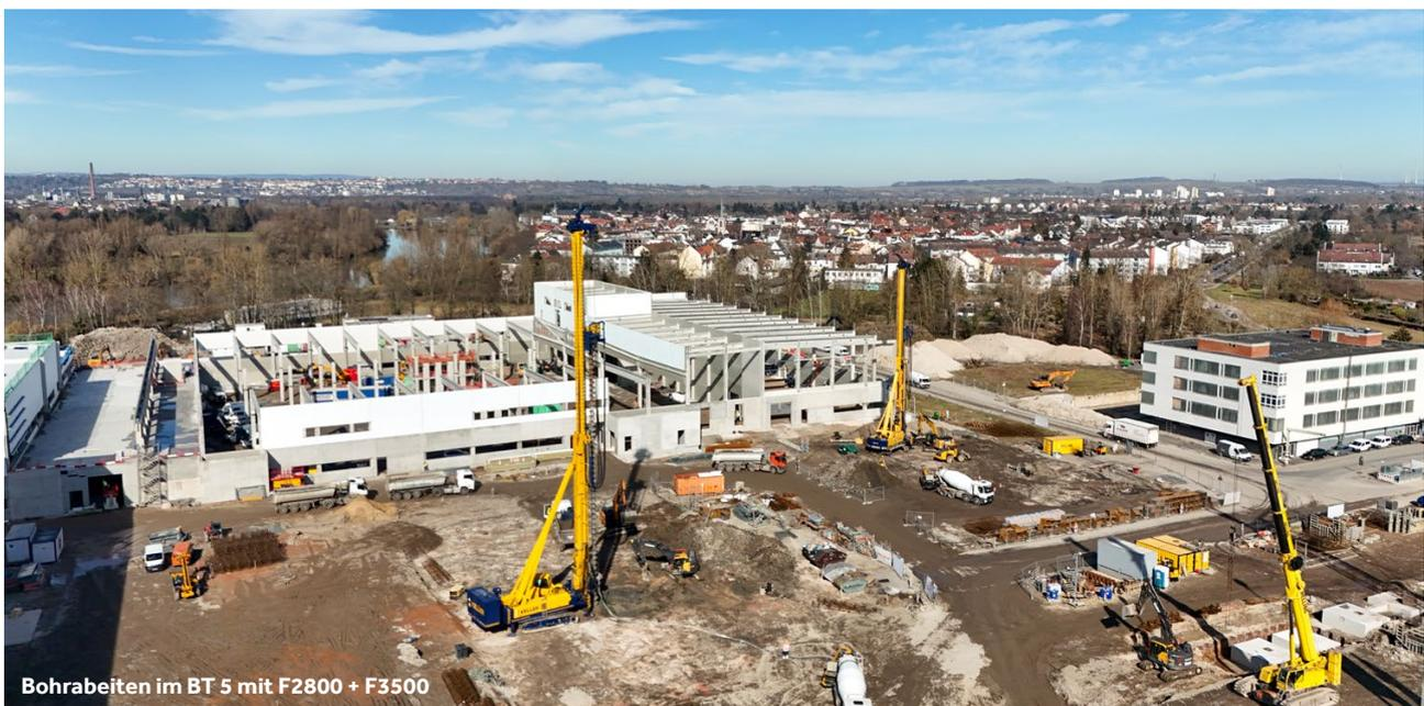
Bohrarbeiten im BT 5 mit F2800 + F3500
