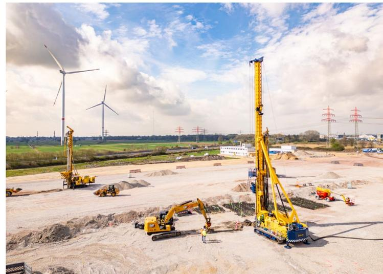
Für die Halle und das Tabaklager wurde ein alternatives Gründungskonzept gewählt: Hier kommen teilvermörtelte Rüttelstopfsäulen unter der Bodenplatte und Verdrängungsbohrpfähle unter den Köcherfundamenten zum Einsatz, die in Kombination eine wirtschaftliche und tragfähige Lösung darstellen.
