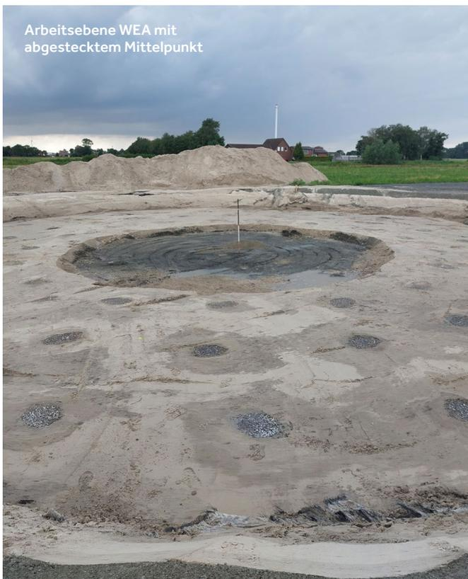
In einem bestehenden Windpark in Ihlow in Niedersachsen sollen 14 neue Windenergieanlagen errichtet werden. Keller Grundbau wurde beauftragt, für neun der Anlagen eine Baugrundverbesserung durchzuführen. Um die statische Anforderung an den Baugrund einzuhalten, wurden die Längen der Rüttelstopfsäulen von 3,5 m bis zu 8 m ermittelt. Vorteil einer Baugrundverbesserung ist die daraus resultierende Möglichkeit einer Flachgründung.
