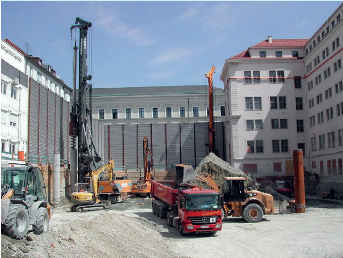
Abbildung 6: Bauseitig ausgeschriebene Lärmschutzwand auf der Baustelle „Neubau Siemens Konzernzentrale“ in München
