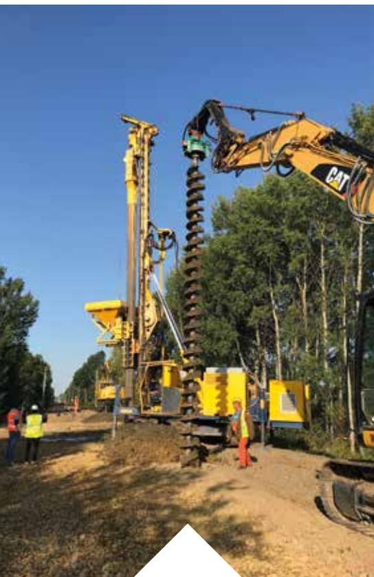
In zwei Bauabschnitten, in denen sich unter dem Schotterbett und der Schutzschicht geologische Störungen in Form von feinkörnigen Böden in unterschiedlicher Konsistenz bis in einer Tiefe von 10 m anstehen, wurden die Rüttelstopfarbeiten eingeordnet.
