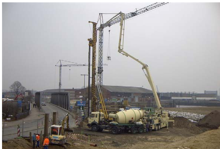
▲ Baustelle Hamburg, Versmannstraße, 2006
