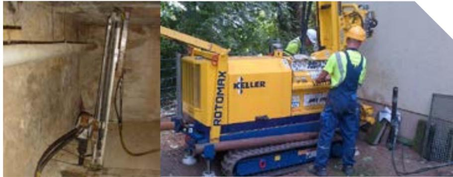
**2 Injektionslanzen / Verpressarbeiten im Außen- sowie Innenbereich**
