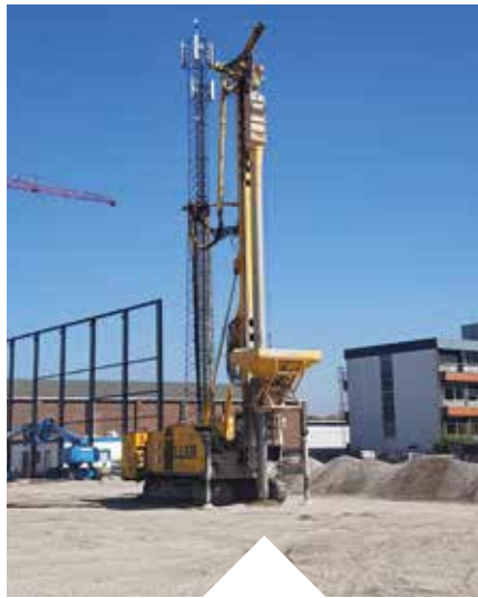
- Betonplatte auf Pfählen aufgelegt
