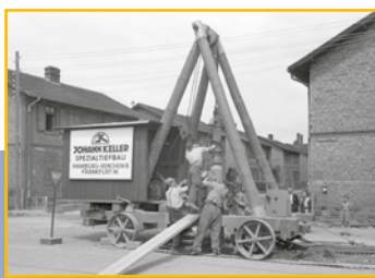
1940 Bodenverbesserung Hanauer Landstraße
