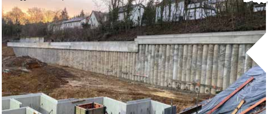
Fertiggestellte Bohrpfahlwand
